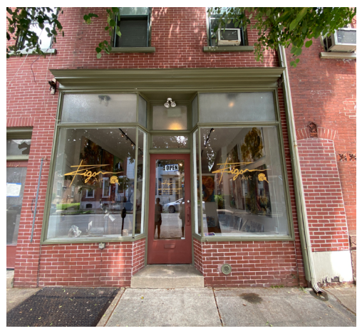
Fachada comercial de madera con entrada empotrada y ventanas de travesaño
