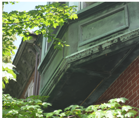
Revestimiento de cobre en el mirador.
