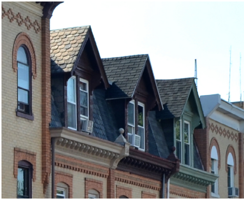
Tres techos muestran las diferencias visuales de los materiales de cubierta: pizarra original (izquierda), teja asfáltica de 3 lengüetas (centro) y teja arquitectónica de anchura abigarrada (derecha).
