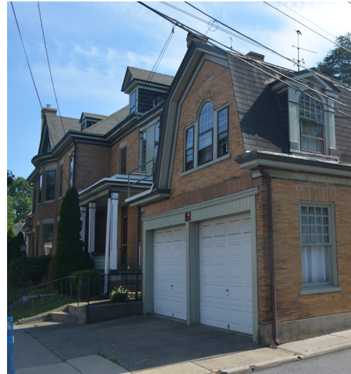
Estructura accesoria con características arquitectónicas distintivas
