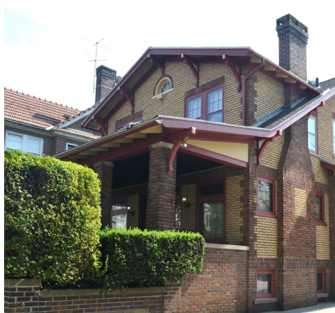
Las chimeneas que conserven detalles originales y estén en consonancia con el estilo arquitectónico del edificio deben preservarse.
