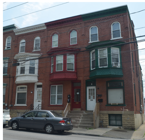
Construcción típica de mampostería de ladrillo
